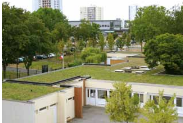
Les couvertures végétalisées des écoles Glycines et Primevères ont amélioré l'isolation thermique et acoustique
